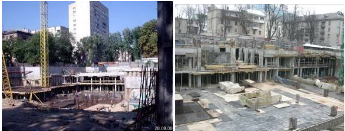
Рисунок 0.3. Хід робіт з будівництва багатоповерхового житлового будинку з вбудовано-прибудованими приміщеннями громадського призначення та підземного паркінгу по вул. Білоруській, 36-а у Шевченківському районі м. Києва станом на кінець серпня 2008 року та на початок грудня 2008 року
