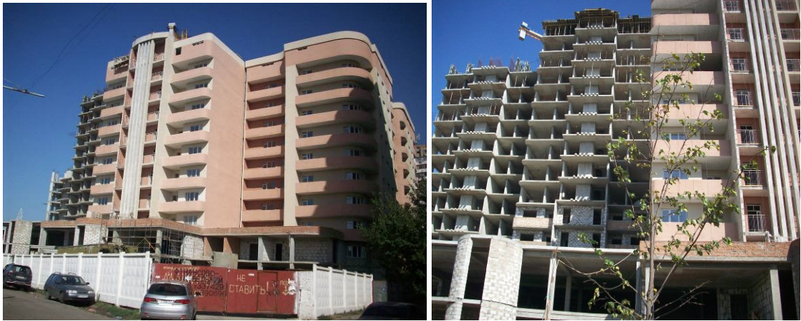
Рисунок 1. Стан будівництва громадсько-житлового комплексу у мікрорайоні ім. Таїрова на розі вул. 25-ї Чапаївської дивізії та просп. Маршала Жукова у м. Одесі на 07.09. 2009 р.
