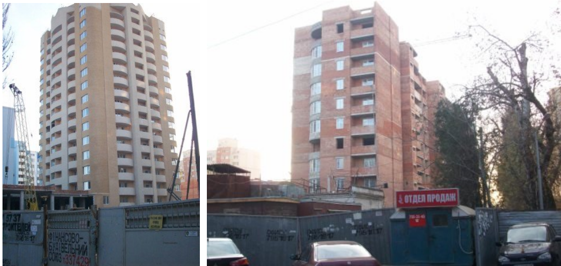
Рисунок 4. Стан будівництва громадсько-житлового комплексу по вул. М. Говорова, 10 А у м. Одесі на 26.11.2009 р.
