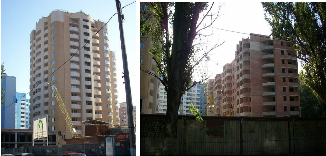
Рисунок 3. Стан будівництва громадсько-житлового комплексу по вул. М. Говорова, 10 А у м. Одесі на 07.09.2009 р.
