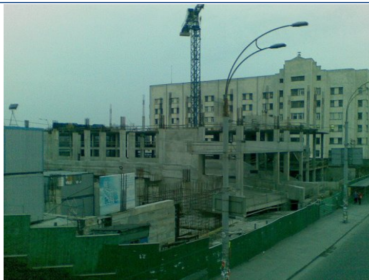
Стан будівництва офісної будівлі за адресою: м. Київ, пров. Індустріальний, 1-А на 02.05.2010 р.
