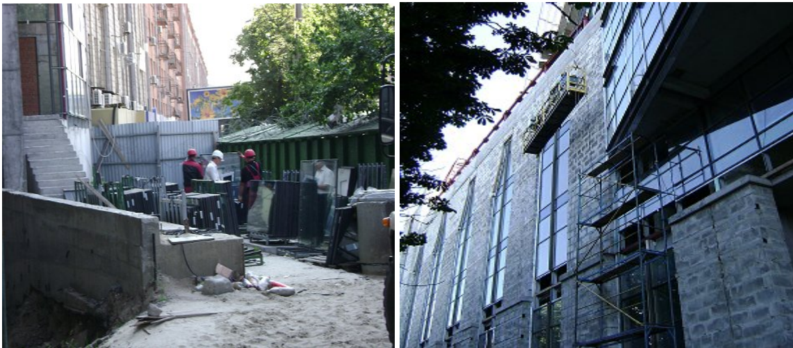
Хід робіт на об'єкті будівництва по вул. Мельникова, 2/10, станом на 18.06.2009 р.
