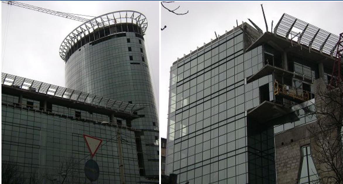
Хід робіт на об'єкті будівництва по вул. Мельникова, 2/10, станом на 19.03.2009 р.
