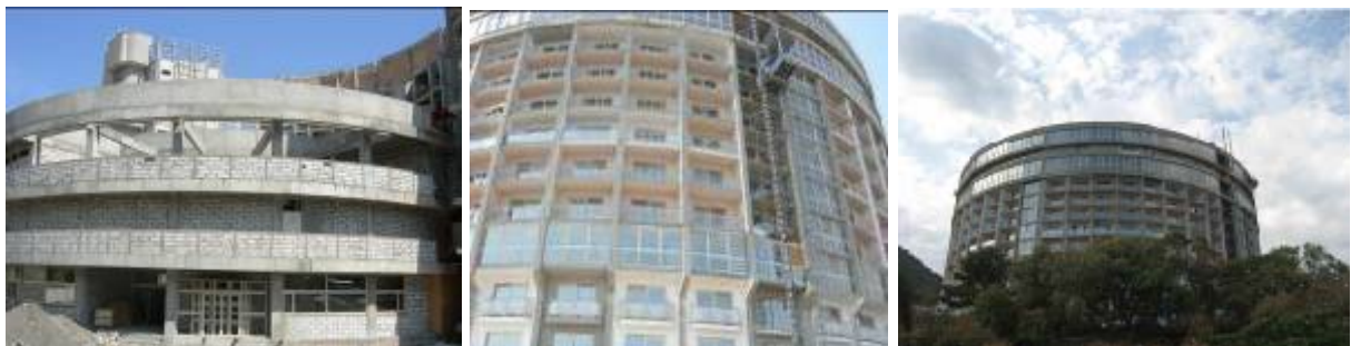
Хід робіт з будівництва одинадцятиповерхового оздоровчого комплексу «GRAND CRUISE HOTEL»
