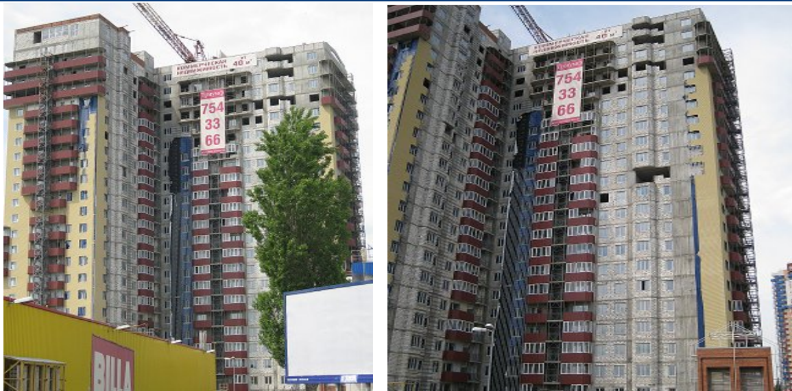
Хід робіт на об'єкті будівництва по вул. 23 Серпня (в районі буд. 31) у м. Харкові станом на 22.05.2009 р.
