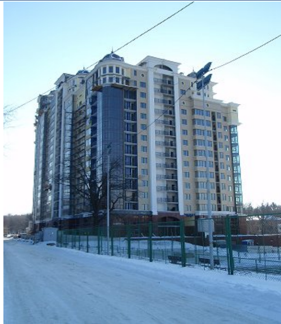
Стан будівництва житлового комплексу по вул. Фронтівій, 3 у м. Харкові станом на кінець січня 2012 року
