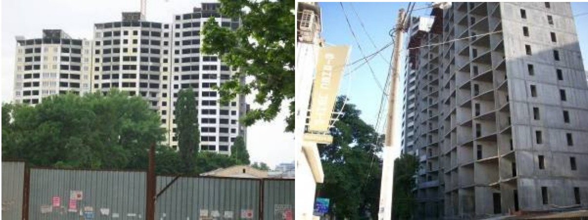
Будівництво житлового комплексу вул. Армійській, 11 станом на 29.05.2009 р. та станом на 08.09.2009 р.
