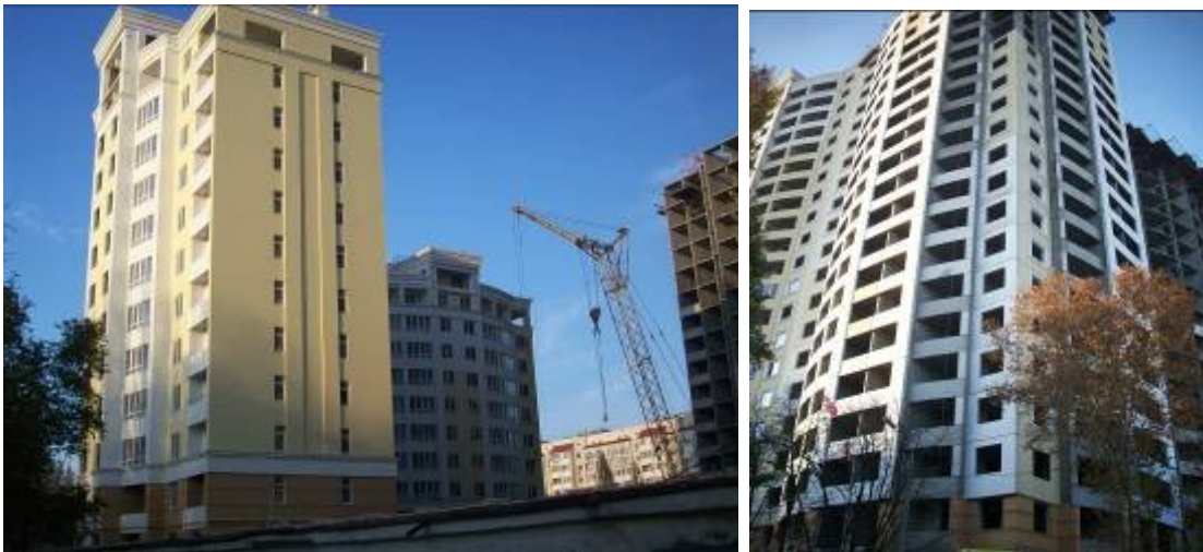
Будівництво житлового комплексу вул. Армійській, 11 станом на 26.11.2009 р.
