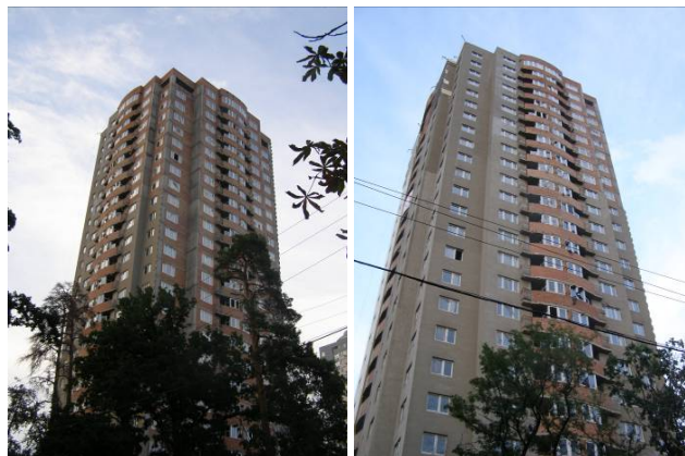
Хід робіт на об'єкті будівництва житлового будинку по вул. Львівській, 26 м. Київ станом на 24.06.2009 р.
