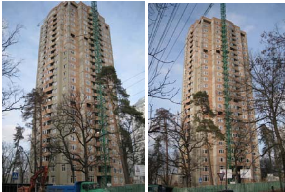
Хід робіт на об'єкті будівництва житлового будинку по вул. Львівській, 26 м. Київ станом на 05.03.2009 р.
