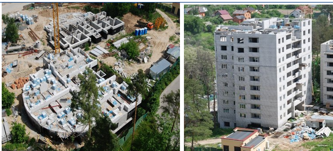
Будівництво житлового комплексу (II черга) по вул. Лобановського, 1 у с. Чайці Києво-Святошинського району Київської області станом на початок травня 2012 року (зліва на право: будинок №8, будинок №9)
