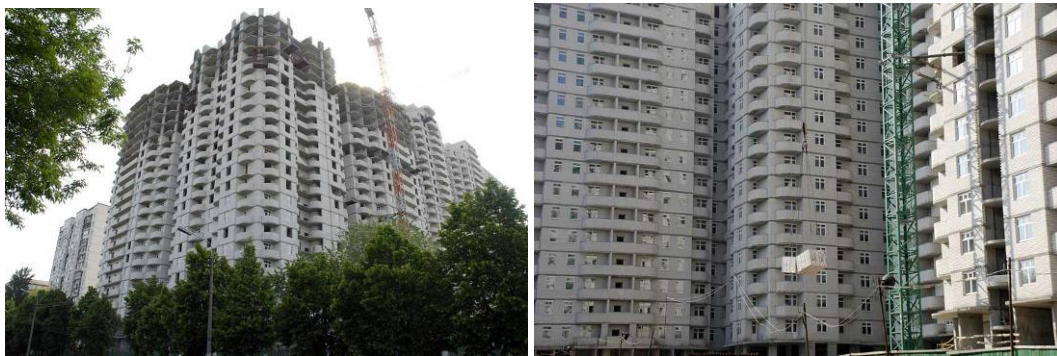
Рисунок 1.2. Будівельні роботи по вул. Майорова, 5А станом на середину травня 2009 року
