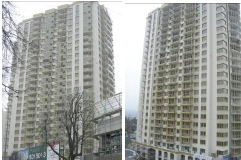
Хід будівництва житлового комплексу «Парк Авеню» (I черга) станом на 03.12.2009 р. (зліва-направо): будинок № 1 та будинок № 2
