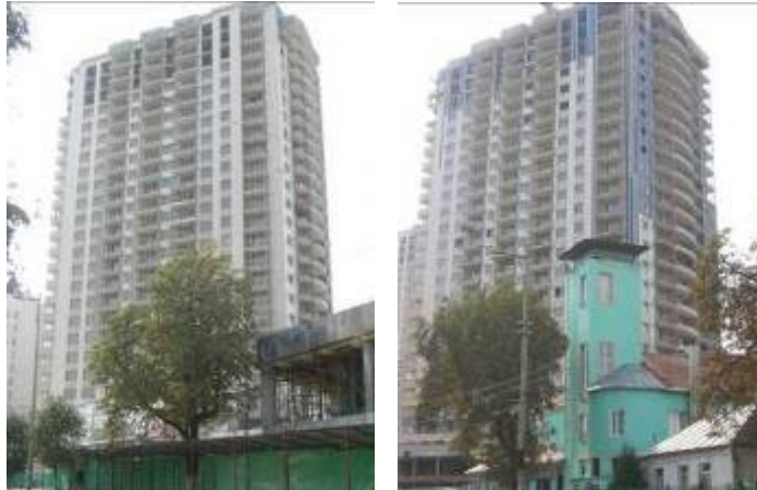
Хід будівництва житлового комплексу «Парк Авеню» (I черга) станом на 15.09.2009 р. (зліва-направо): будинок № 1 та будинок № 2
