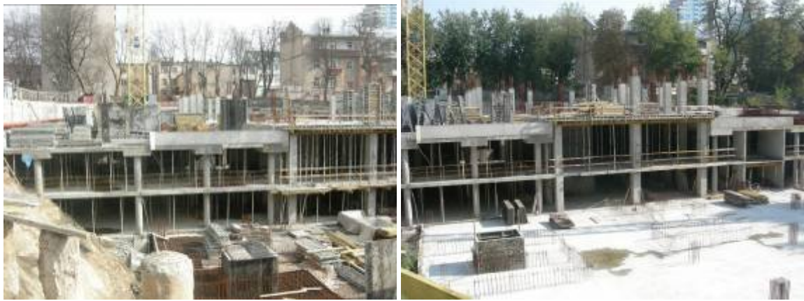
Хід робіт з будівництва багатоповерхового житлового будинку з вбудовано-прибудованими приміщеннями громадського призначення та підземного паркінгу по вул. Білоруській, 36-а у Шевченківському районі м. Києва станом на кінець березня 2009 року та на вересень 2009 року
