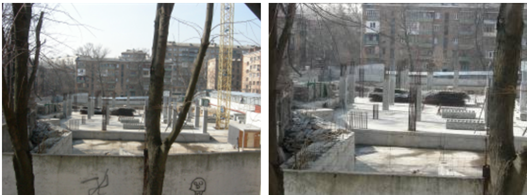
Об'єкт будівництва - багатоповерховий житловий будинок з вбудовано-прибудованими приміщеннями громадського призначення та підземний паркінг по вул. Білоруській, 36-а у Шевченківському районі м. Києва станом на березень 2010 року
