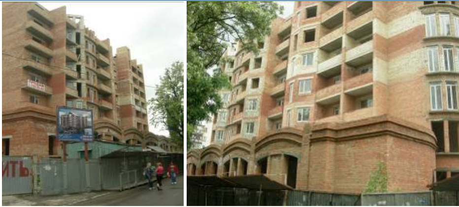
Будівництво житлового будинку по пров. Черепанових, 12 у м. Одесі станом на травень 2010 року
