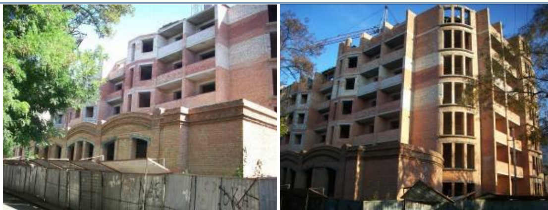
Будівництво житлового будинку по пров. Черепанових, 12 у м. Одесі станом на вересень та листопад 2009 року
