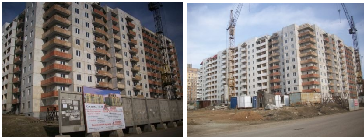
Рисунок 6. Стан будівельної готовності житлового будинку № 19 та №20 у мікрорайоні III-4-3 Котовського у м. Одесі станом на березень 2010 р.
