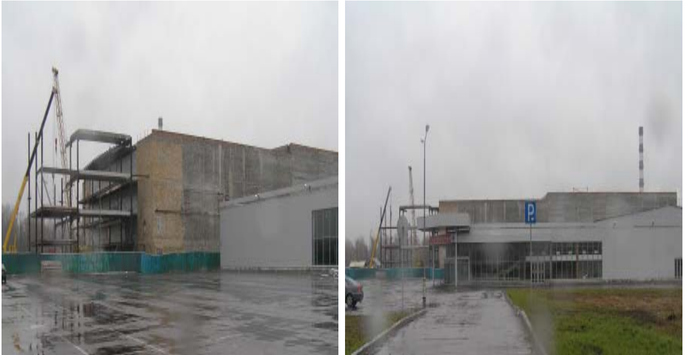
будівництво торговельно-розважального центру, станом на 17.11.2005 року
