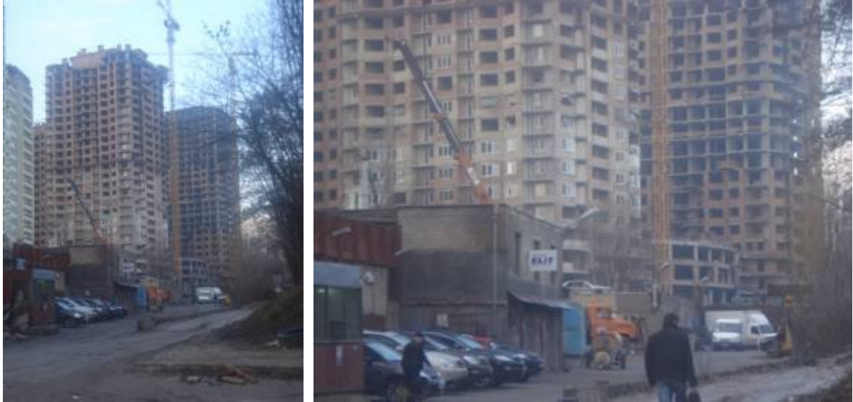
Рисунок 1. Будівельні роботи на об'єкті будівництва житлового комплексу по вул. Механізаторів, 2 (ж/к «Ізумрудний») у Солом'янському районі м. Києва станом на 21.11.2009 р.
