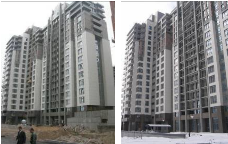
Ж/б 5 по вул. Професора Підвисоцького у Печерському районі м. Києва
