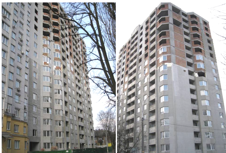
Будівництво житлового будинку по вул. Краснова, 19, Святошинський район м. Києва, станом на 01.05.2009 р.
