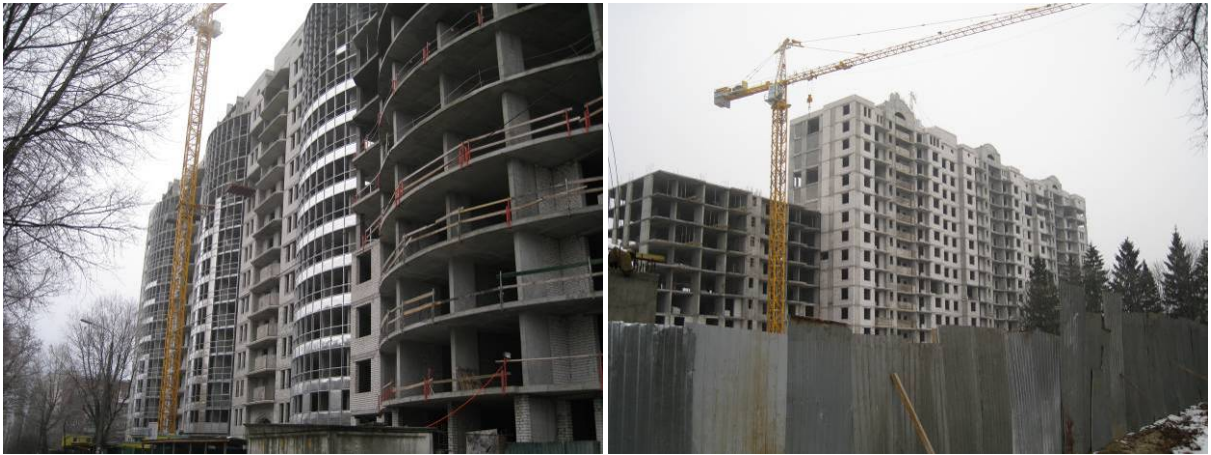
Будівництво житлового будинку по вул. Васильківській, 31/17, Голосіївський район м. Києва станом на 05.03.2009 р.
