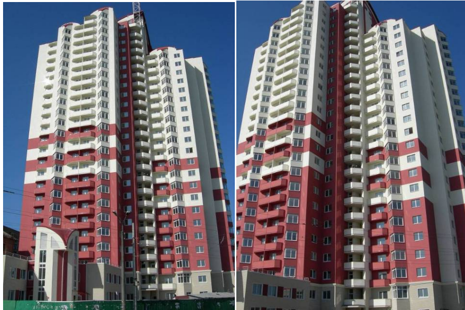
Житловий будинок по вул. Санаторній, 4, Дарницький район м. Києва
