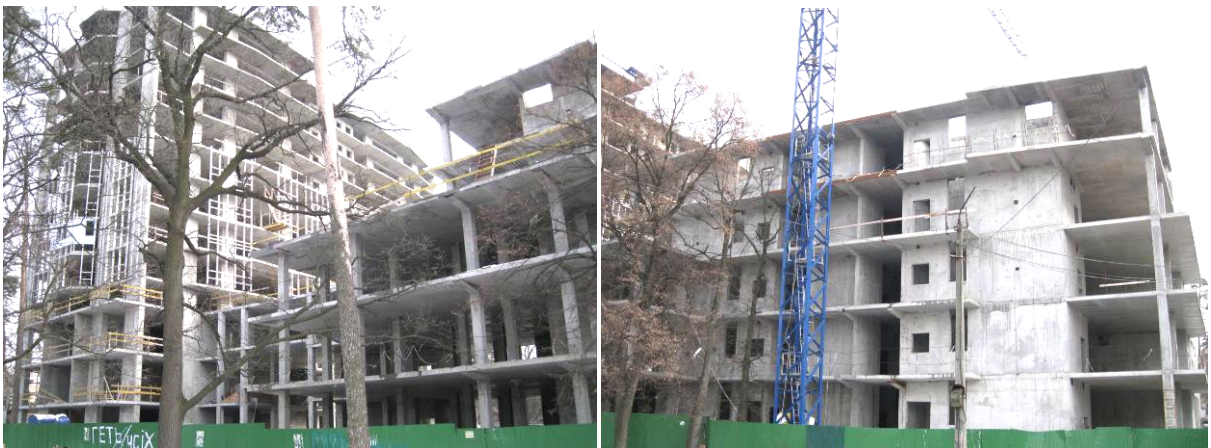
Будівництво житлового будинку по пр. Перемоги, 115-а, Святошинський район м. Києва, станом на 01.05.2009 р.
