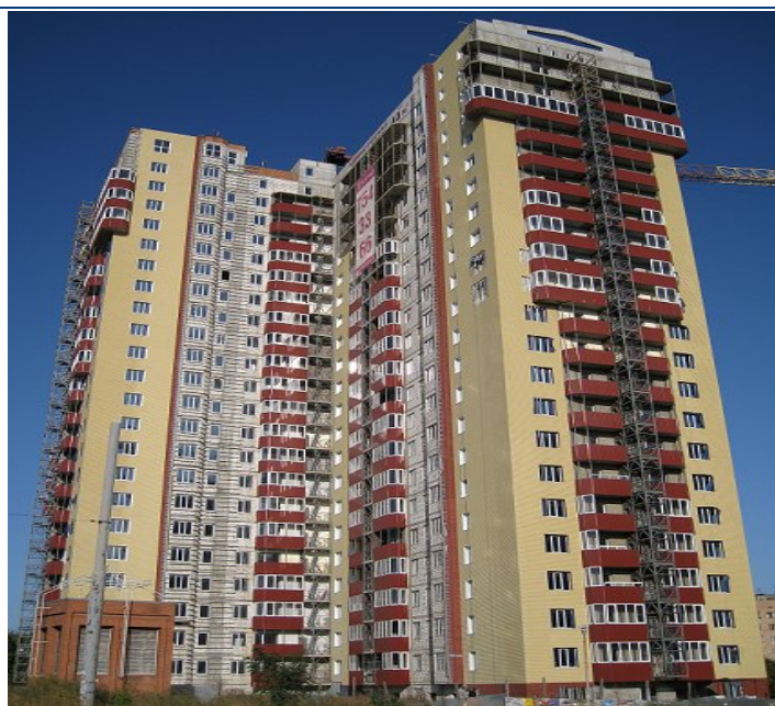
Хід робіт на об'єкті будівництва по вул. 23 Серпня (в районі буд. 31) у м. Харкові станом на 21.08.2009 р.
