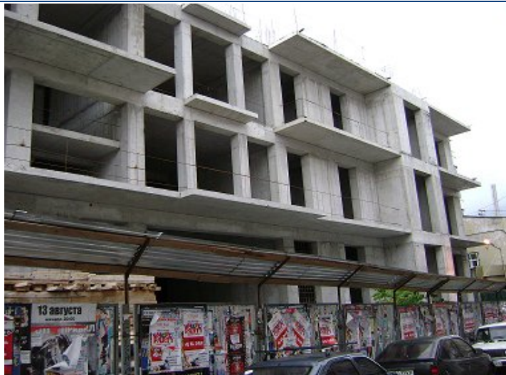
Хід робіт на об'єкті будівництва по вул. Ігнатенко, 9 у м. Ялті станом на 19.11.2009 р.
