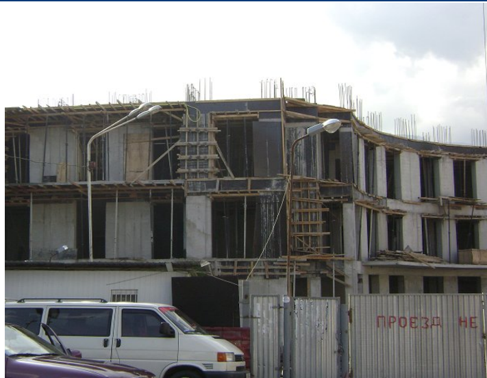
Хід робіт на об'єкті будівництва по вул. Ігнатенко, 9 у м. Ялті станом на 21.08.2009 р.
