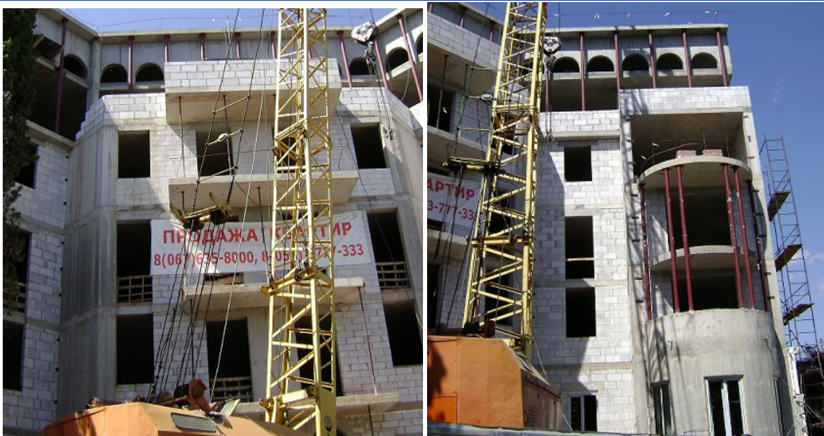
Стан будівництва житлового будинку по вул. Батуріна, 44А у смт. Лівадія м. Ялти станом на 21.08.2009 р.
