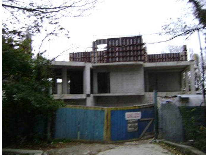
Хід будівництва рекреаційного комплексу по вул. Луговського в смт. Сімеїз станом на 19.11.2009 р.
