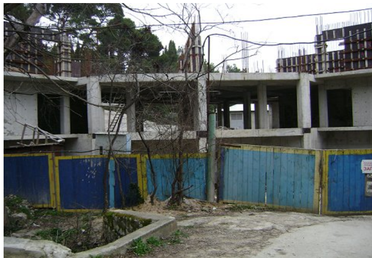
Хід будівництва рекреаційного комплексу по вул. Луговського в смт. Сімеїз станом на 04.03.2010 р.
