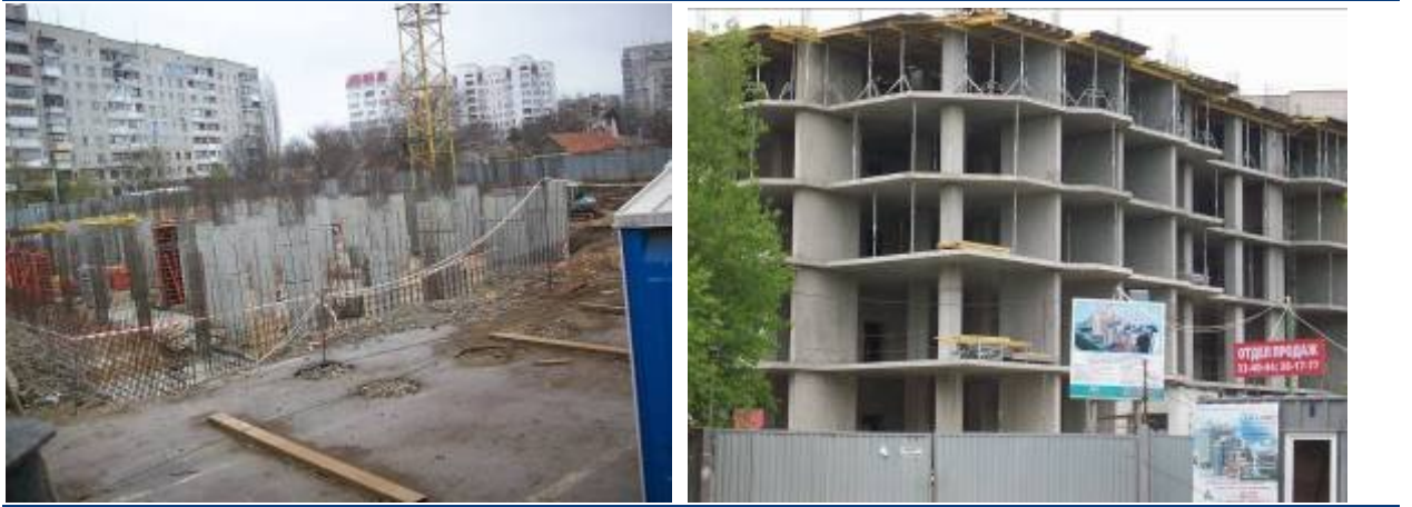
Хід робіт на об'єкті будівництва по вул. Малиновського (на розі вул. Заводської та пров. Союзного) в м. Одесі станом (зліва - направо) на середину лютого 2009 р. та на кінець травня 2009 р.
