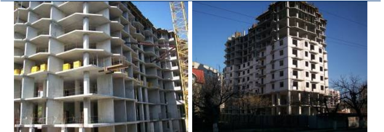
Хід робіт на об'єкті будівництва по вул. Малиновського (на розі вул. Заводської та пров. Союзного) в м. Одесі станом на початок вересня 2009 р. та на кінець листопада 2009 р.
