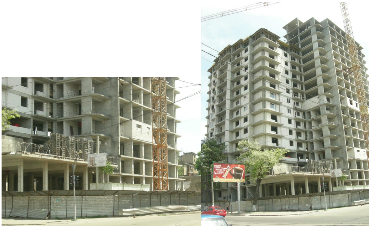
Рисунок 2. Стан будівництва житлового будинку по вул. Прохорівській, 39-41 у м. Одесі, на 25.05.2010 р.
