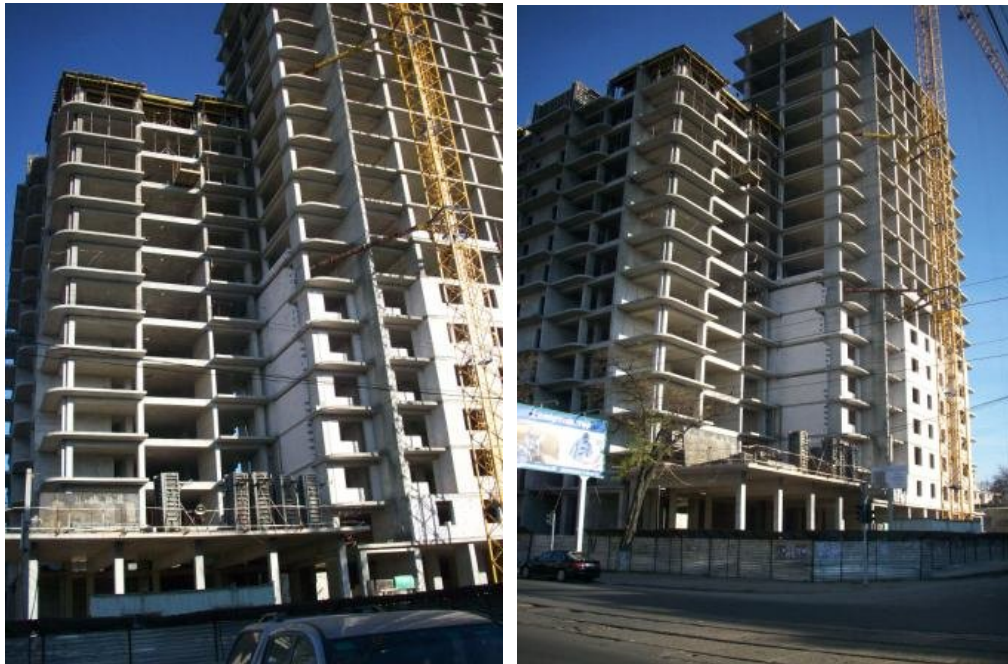
Рисунок 1. Стан будівництва житлового будинку по вул. Прохорівській, 39-41 у м. Одесі, на 26.11.2009 р.
