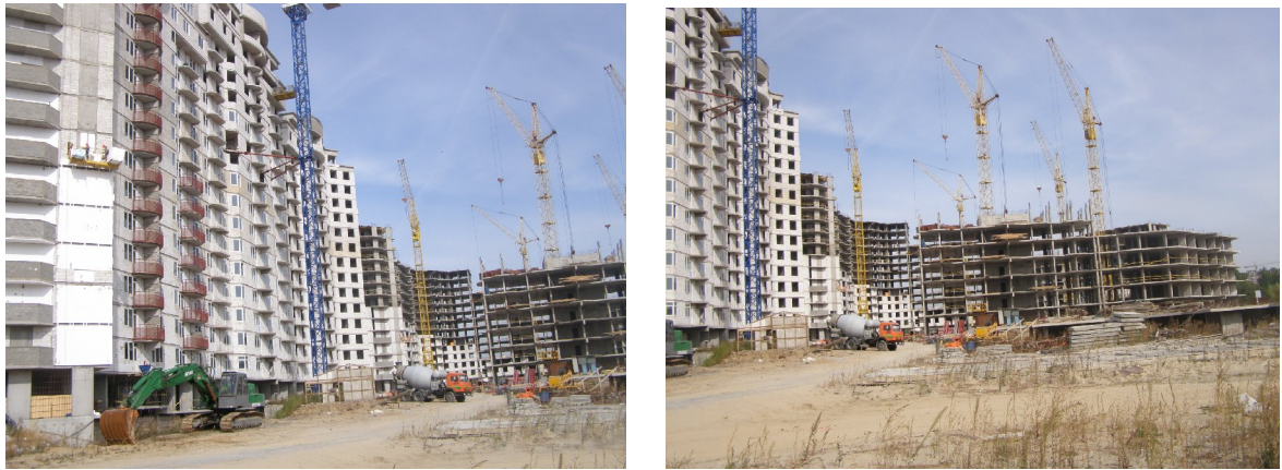
Рисунок 1. Стан будівництва житлових будинків з підземними паркінгами та закладів з обслуговування населення по вул. Вільямса,7 та вул. Ломоносова, 42-50 (III мікрорайон) у м. Києві на 28.09.2009 р.
