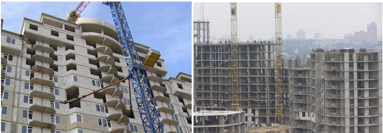
Рисунок 2. Стан будівництва житлових будинків з підземними паркінгами та закладів з обслуговування населення по вул. Вільямса,7 та вул. Ломоносова, 42-50 (III мікрорайон) у м. Києві станом на жовтень 2009 р.
