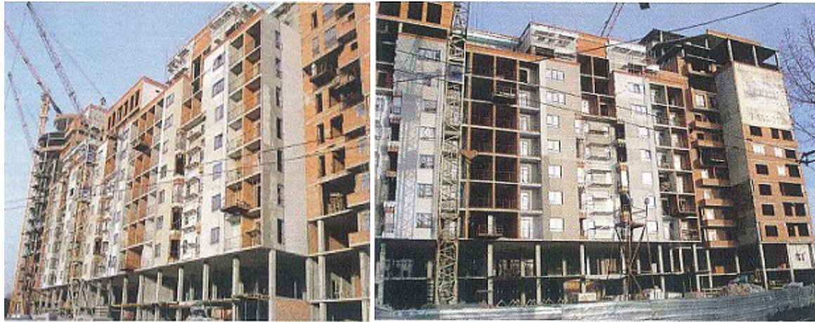
Хід робіт на об'єкті будівництва по пров. Банному в м. Харкові станом на 01.01.2009 р.
