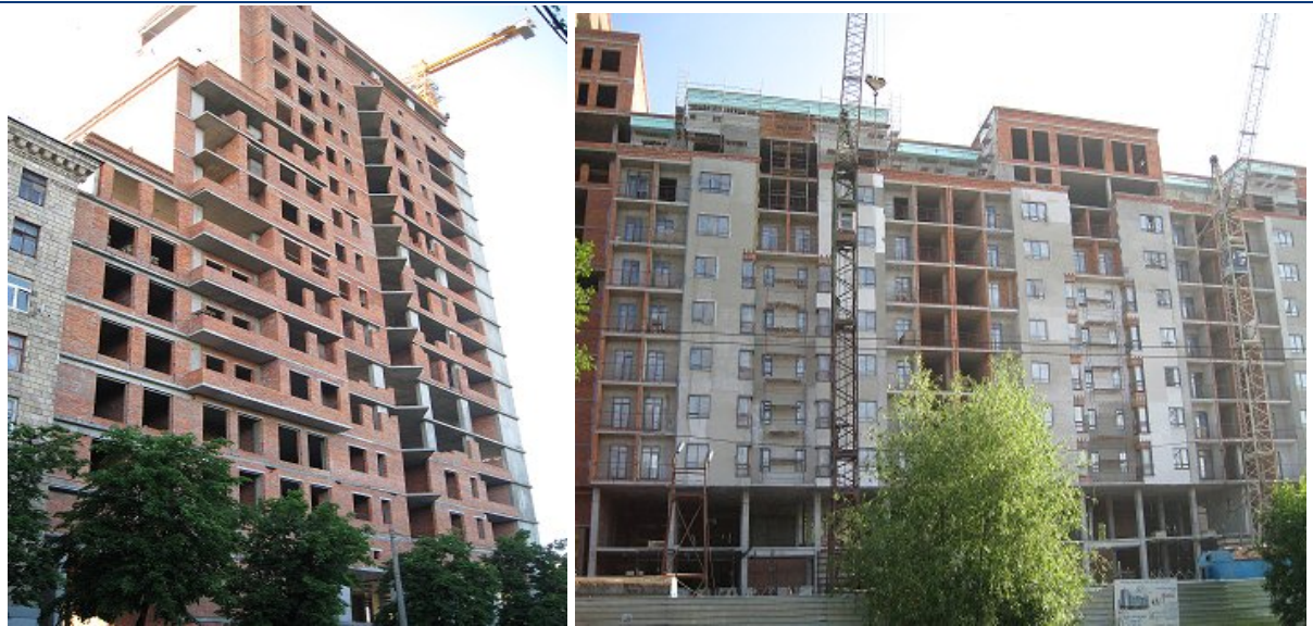
Хід робіт на об'єкті будівництва по пров. Банному в м. Харкові станом на 22.05.2009 р.
