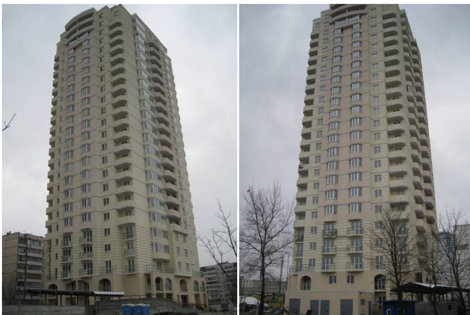
Будівництво житлового будинку у м. Києві на розі вулиці Героїв Дніпра та проспекту Героїв Сталінграду станом на 22.03.2009 р.
