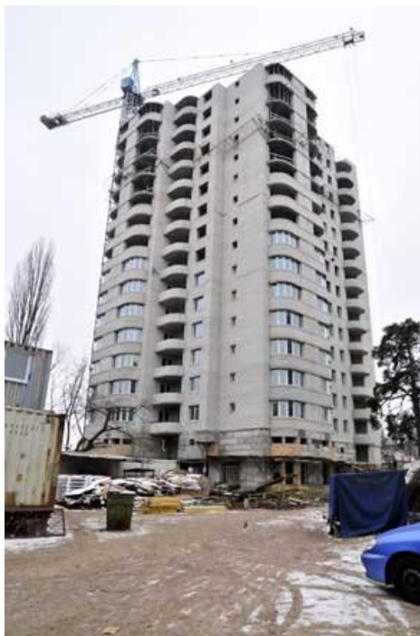
Будівництво житлового будинку по бул. Я. Гашека, 8а станом на кінець 2008 р.
