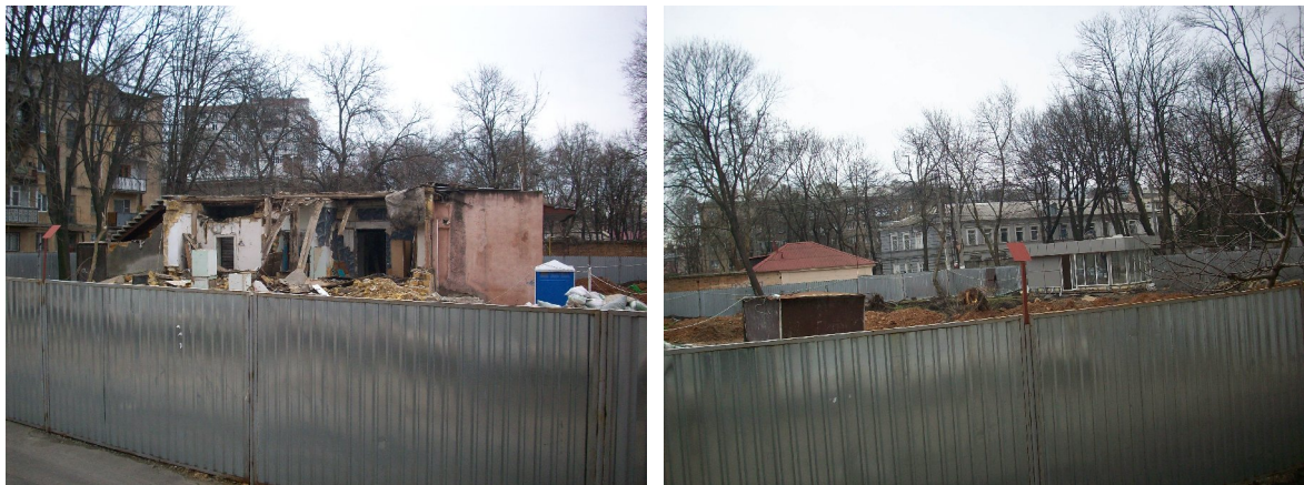
Стан будівельного майданчику по проекту житлового будинку по Французькому бульвару, 13-А в м. Одесі станом на початок березня 2010 р.
