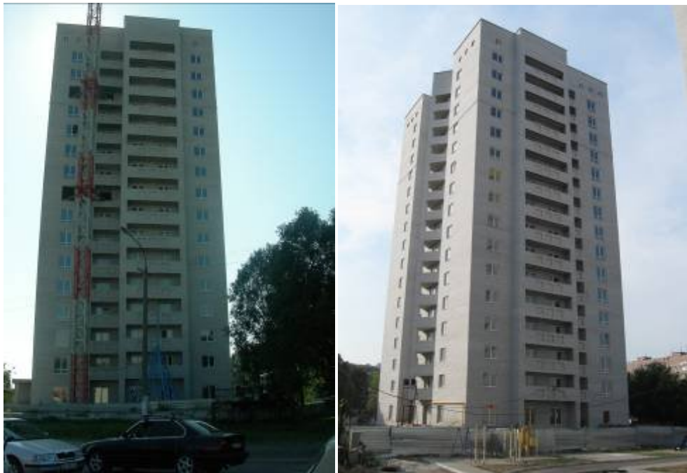
Ступінь будівельної готовності об'єкта в районі вулиць Космічної та Мандриківської, м. Дніпропетровськ (друга черги) станом: (зліва-направо): на кінець травня 2009 року та на вересень 2009 року
