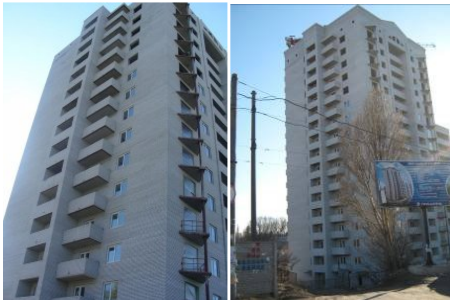
Об'єкт по вул. Тополиній, 7, м. Дніпропетровськ станом на 23.06.2008 р. та станом на листопад 2008 року та станом на кінець лютого 2009 року
