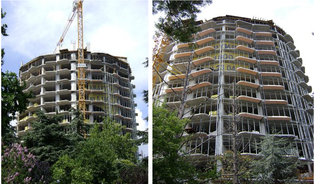
Будівництво багатоповерхового житлового будинку по вул. К. Маркса, 18а у м. Ялті станом на 27.08.2010 р
