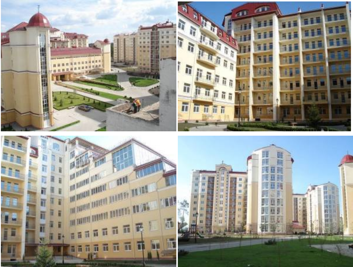
Перша черга житлового комплексу в Київській області с. Чайки по вул. Лобановського, 1
