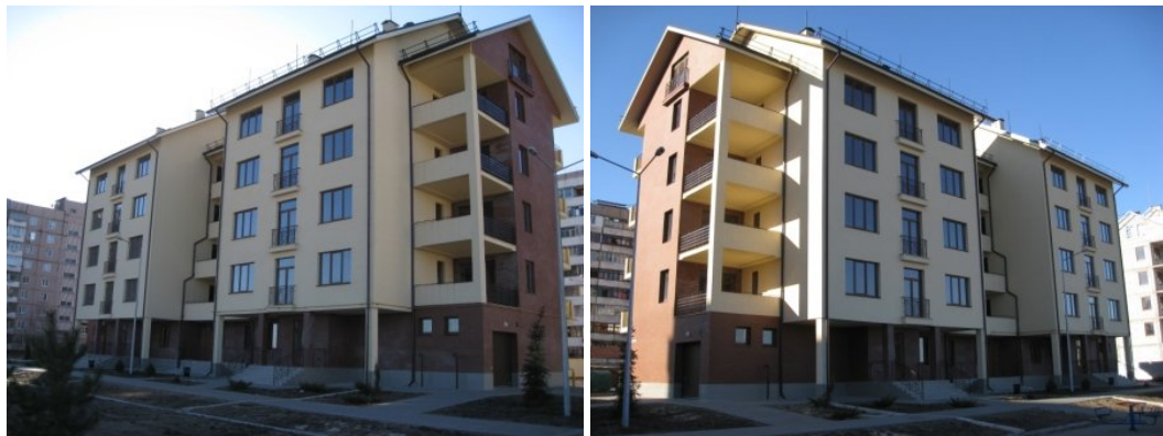
Рисунок 4. Житловий будинок №5 по вул. Медичній у м. Запоріжжі станом на березень 2010 року
