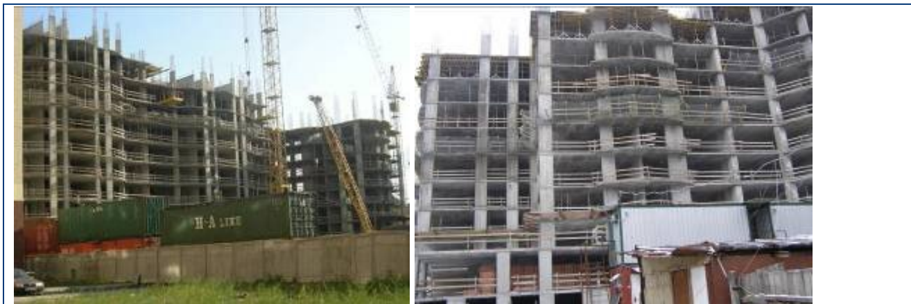
Будівельні роботи на секціях 1-3 житлового будинку № 26 станом на кінець вересня 2008 року та на середину лютого 2009 року
