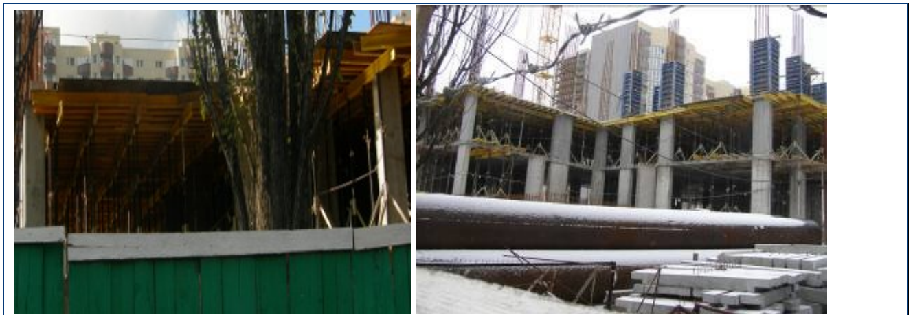
Будівельні роботи на секціях 1-4 житлового будинку № 28 станом кінець вересня 2008 року та на середину лютого 2009 року
