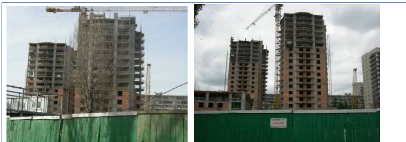
Будівельні роботи по житловим будинкам №№ 33 та 34 станом на початок 2008 року та станом на початок травня 2008 року
