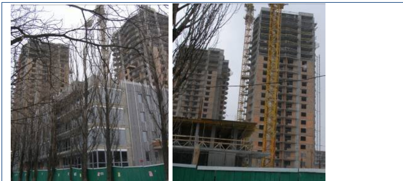
Будівельні роботи по житловим будинкам №№ 33 та 34 та адміністративному будинку № 36 станом на середину лютого 2009 року
