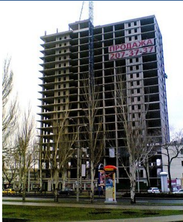
Хід робіт на об'єкті будівництва комплексу по вул. Артема (на перетинанні пр. Ватутіна) в Ворошиловському районі м. Донецьку станом на початок квітня 2011 року
