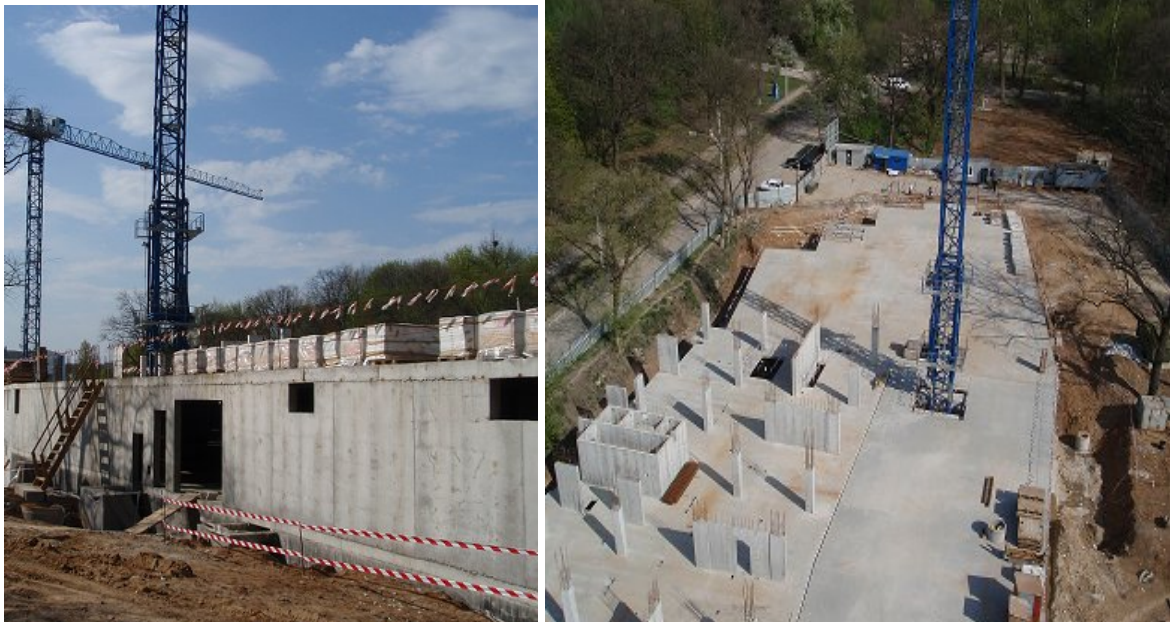
Стан будівництва житлового комплексу по вул. Фронтівій, 3 у м. Харкові станом на 30.04.2009 р.
