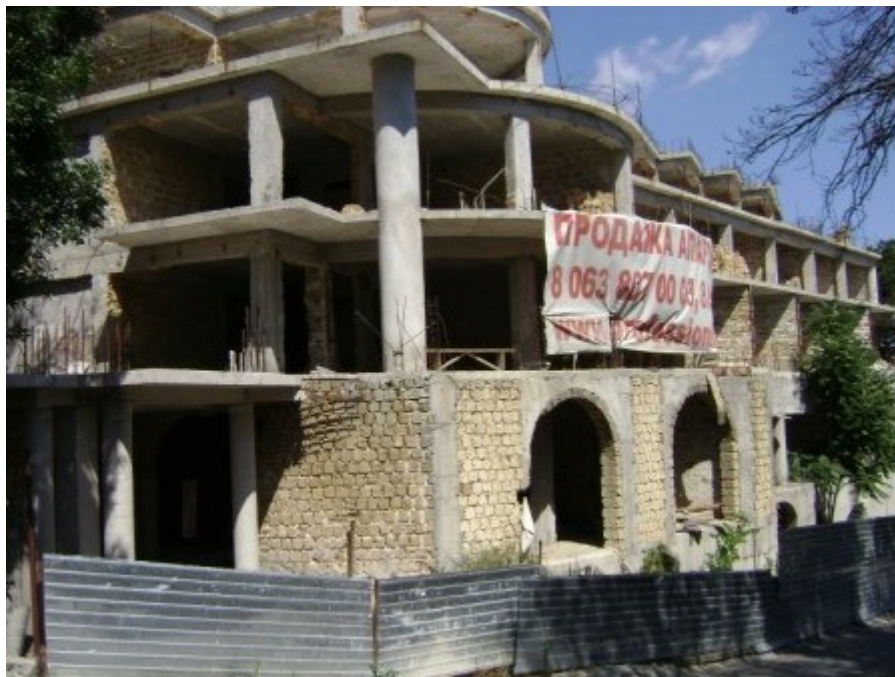
Рисунок 2. Стан будівництва рекреаційного комплексу по вул. Дворцове шосе, 3 у м. Алуці станом на 27.08.2010 р.
