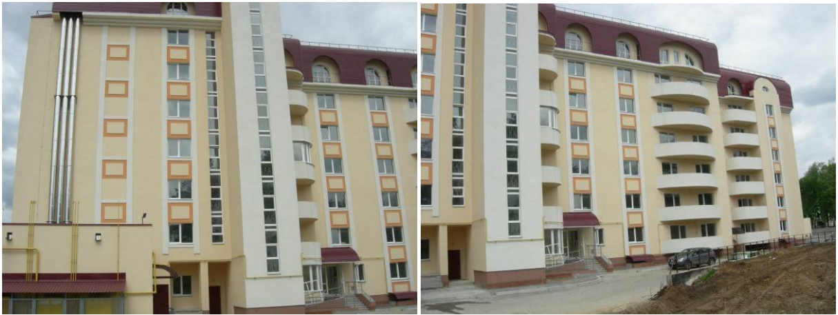
Житловий будинок у с. Чайці по вул. Коцюбинського буд. 6, Київської області
