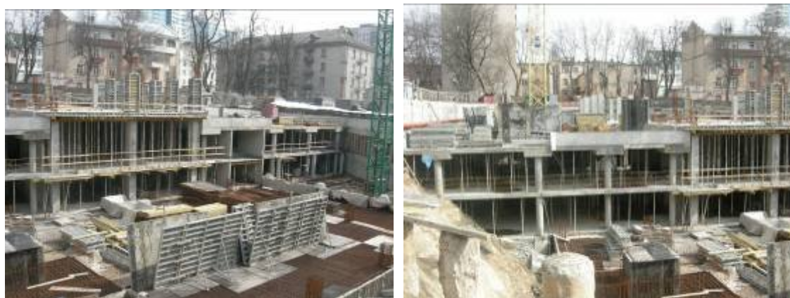
Хід робіт з будівництва багатоповерхового житлового будинку з вбудовано-прибудованими приміщеннями громадського призначення та підземного паркінгу по вул. Білоруській, 36-а у Шевченківському районі м. Києва станом на кінець березня 2009 року
