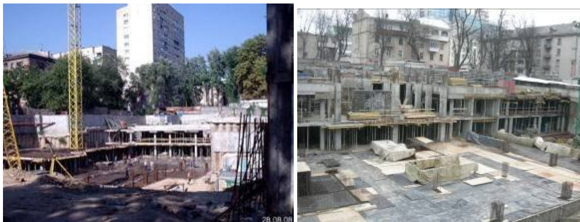
Хід робіт з будівництва багатоповерхового житлового будинку з вбудовано-прибудованими приміщеннями громадського призначення та підземного паркінгу по вул. Білоруській, 36-а у Шевченківському районі м. Києва станом на кінець серпня 2008 року та на початок грудня 2008 року
