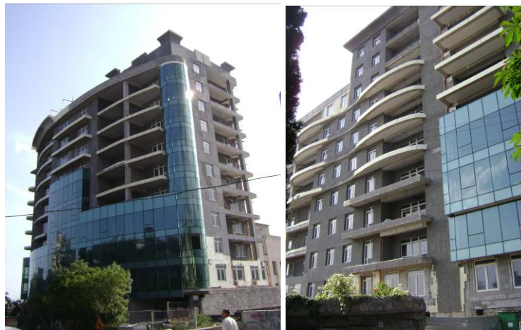
Хід робіт на об'єкті будівництва житлового комплексу «Адміралтейський» класу «люкс» по вул. Руданського, буд. 8 Б станом на початок червня 2009 року
