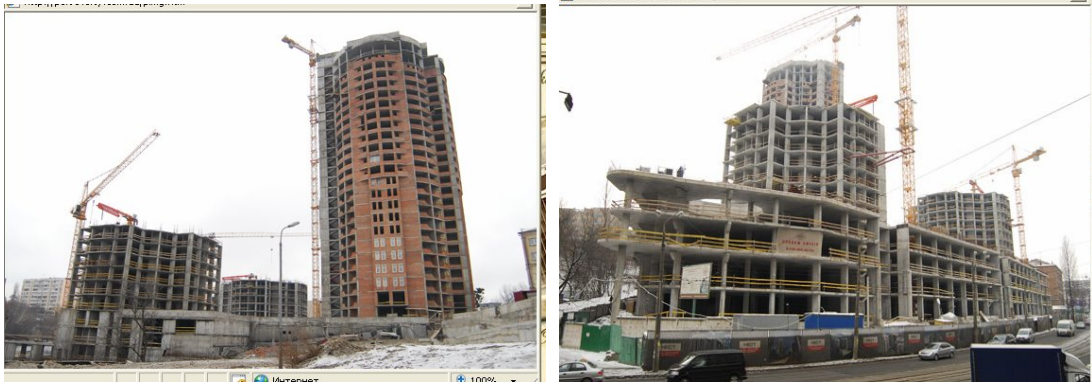
Рисунок 1.1. Будівельні роботи на об'єкті будівництва офісно-житлового комплексу в м. Києві на ділянці, обмеженої вулицями Глибочицькою, Студентською та Пимоненка станом на 01.02.2009 р
