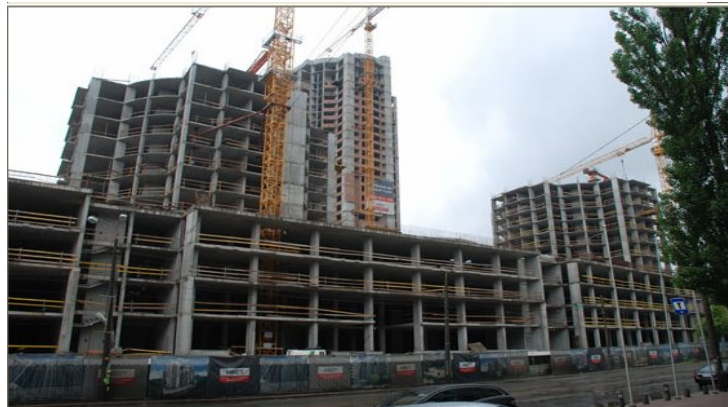
Рисунок 1.2. Будівельні роботи на об'єкті будівництва офісно-житлового комплексу в м. Києві на ділянці, обмеженої вулицями Глибочицькою, Студентською та Пимоненка станом на 01.06.2009 р.
