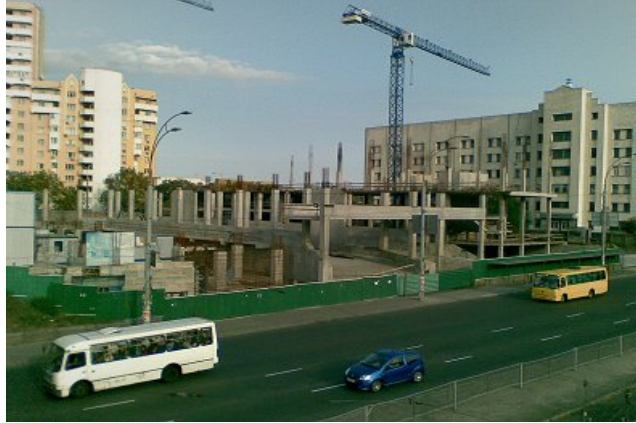
Стан будівництва офісної будівлі за адресою: м. Київ, пров. Індустріальний, 1-А на 14.11.2009 р.
