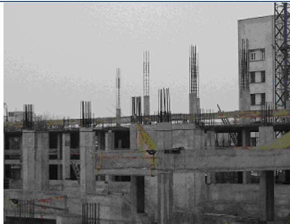
Стан будівництва офісної будівлі за адресою: м. Київ, пров. Індустріальний, 1-А на 02.03.2010 р.
