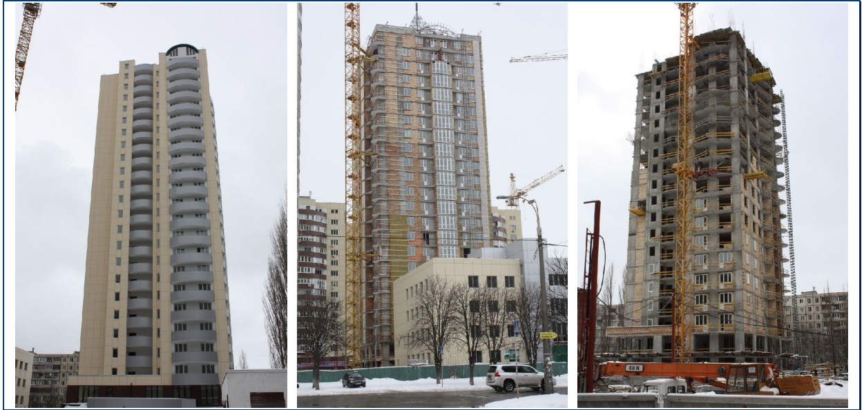
Будівельні роботи по житловим будинкам № 33, 34, 35 станом на березень 2012 року
