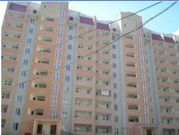
Житловий будинок № 81 у мікрорайоні «Д» Південний у м. Одесі.
