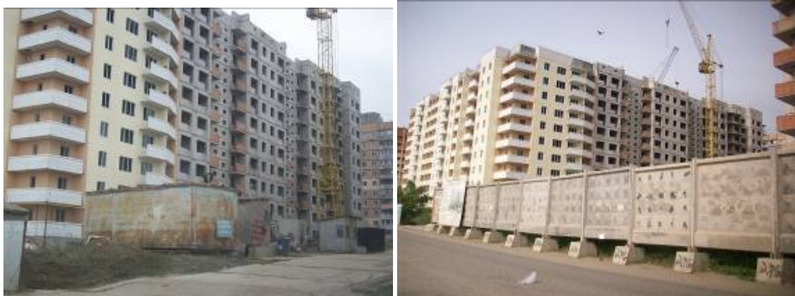
Об'єкт будівництва - житловий будинок № 19 у мікрорайоні III-4-3 Котовського у м. Одесі станом на 20.02.2009 р. та на 29.05.2009 р.
