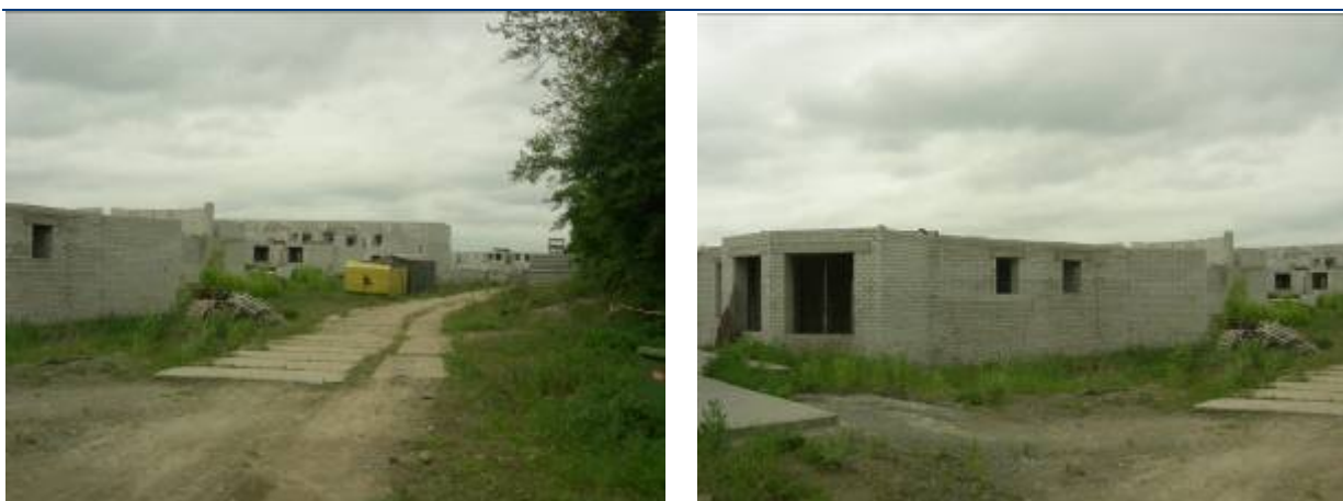
Об'єкт незавершеного будівництва - житловий комплекс з об'єктами соціально-побутової інфраструктури по вул. Леніна, 119 у с. Петропавлівська Борщагівка Києво-Святошинського району Київської області станом на травень 2010 року
