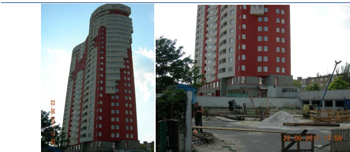
Об'єкт будівництва по вул. П. Запорозця, 26-А у м. Києві станом на середину червня 2011 року
