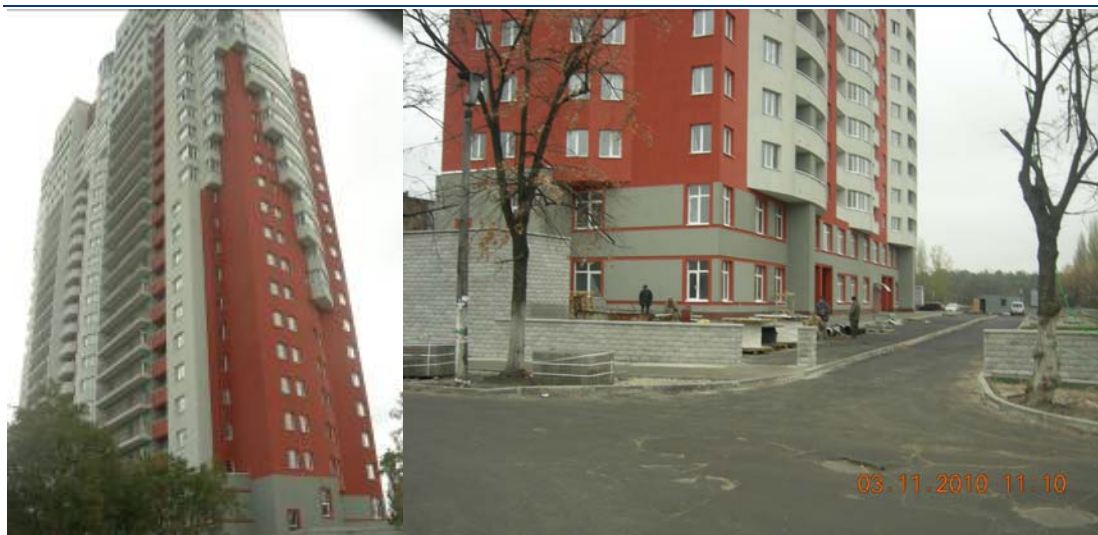
Хід робіт на об'єкті будівництва по вул. П. Запорозця, 26-А у м. Києві станом на середину листопада 2010 року
