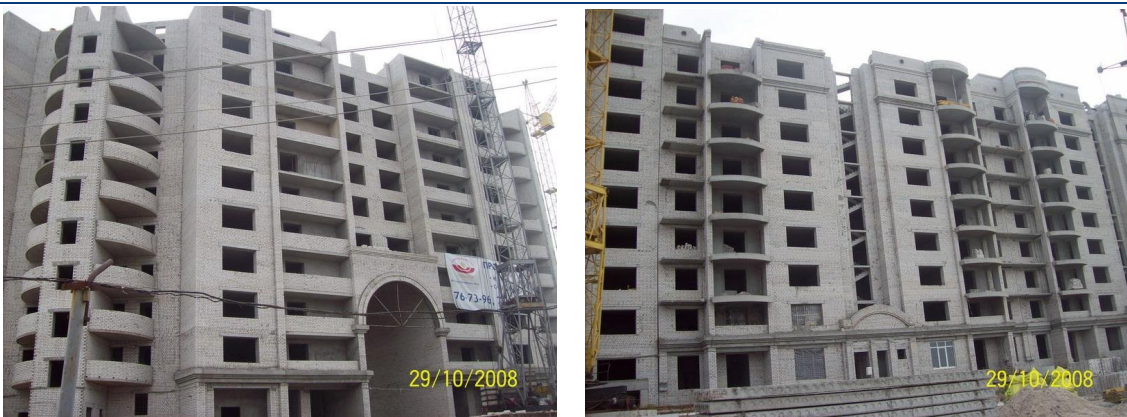
Хід будівництва мікрорайону «Ліски-2» у м. Миколаєві станом на кінець жовтня 2008 року (ж/б №№ 10 та 11)
