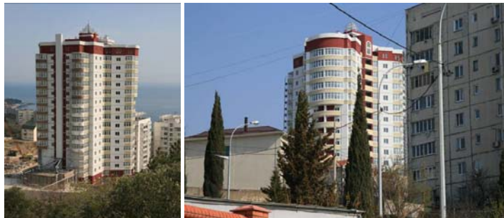
Стан робіт на об'єкті будівництва по вул. Южній, 64-66 (I черга), станом на 05.05.2009 р.
