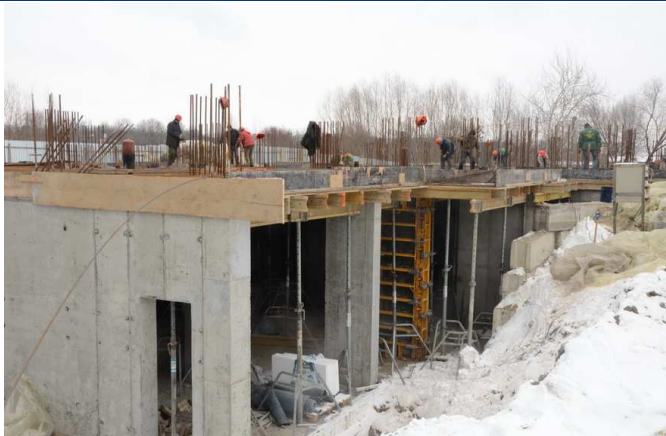
Хід будівництва багатопверхового житлового будинку з вбудованими приміщеннями громадського призначення та підземним паркінгом по пр. В. Чорновола, 67 у м. Львові станом на середину січня 2015 року
